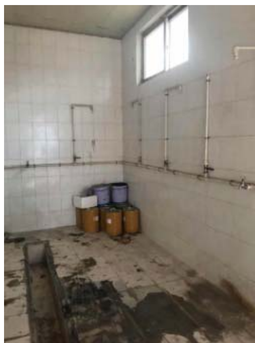
危废暂存间内
