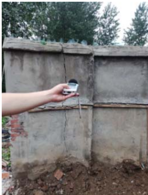
3#厂界西侧外1米处
